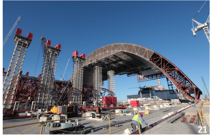
21 Avril 2014 : ripage de la première moitié de l'arche vers la zone d'attente et premier levage de la seconde moitié
