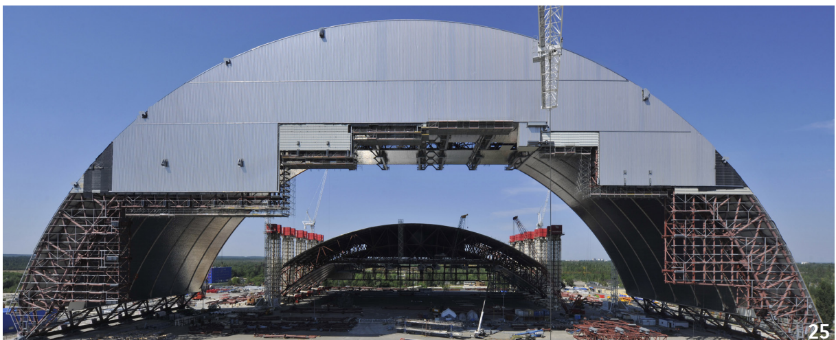
25 Août 2014 : deuxième levage de la seconde moitié de l'arche - ©Francis Vigouroux
