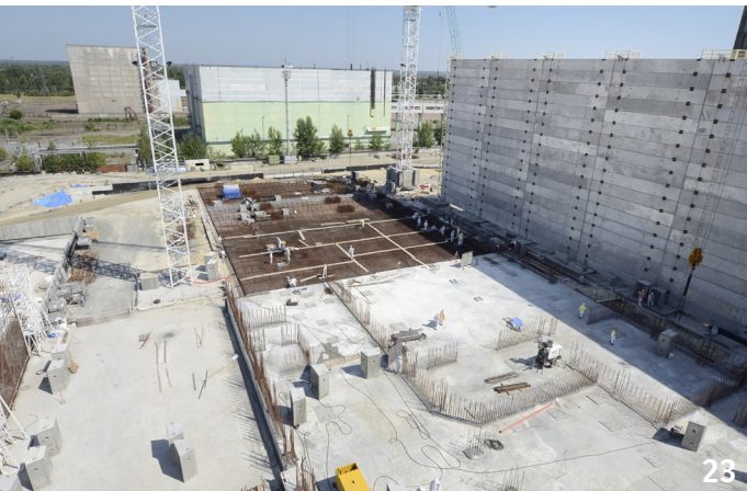
23 Avril 2014 : premiers bétons des fondations du bâtiment technologique (Technological Building) et bâtiments annexes - ©Francis Vigouroux
