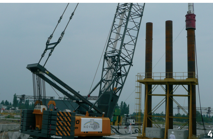
Août 2010 : battage des pieux métalliques des longrines en zone de montage
