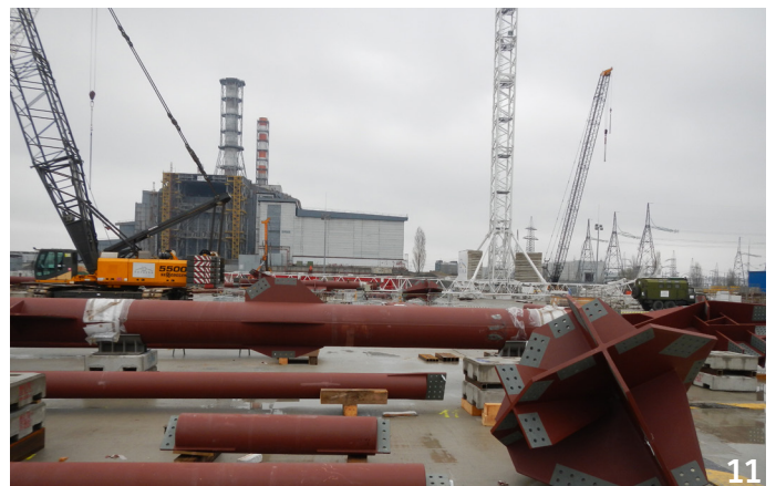
11 Avril 2012 : réception des premiers éléments de l'arche sur site et début du montage de la charpente
