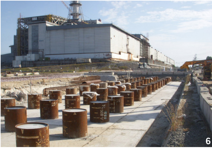
6 Septembre 2011 : réalisation des longrines en zone de montage
