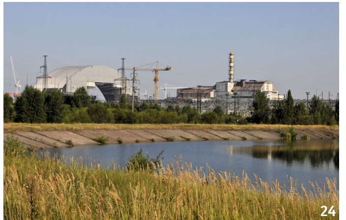
24 Août 2014 : deuxième levage de la seconde moitié de l'arche ©Francis Vigouroux
