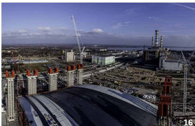
Novembre 2012 : première opération de levage de l'arche @Jean-Yves Govin Sorel
