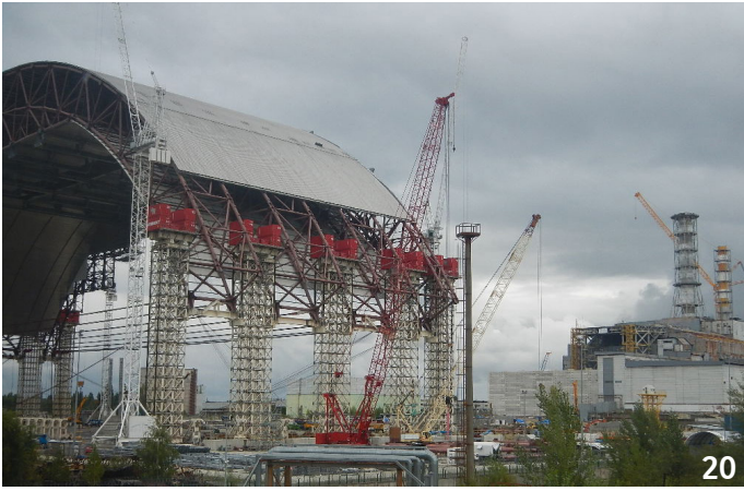
20 Septembre 2013 : troisième opération de levage pour la première moitié de l'arche
