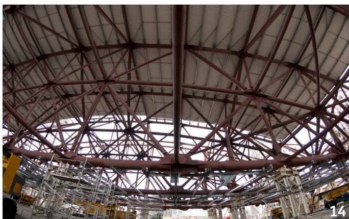
Octobre 2012 : le bardage démarre avec la pose des pannes et du complexe de parois - @Guillaume Daveau
